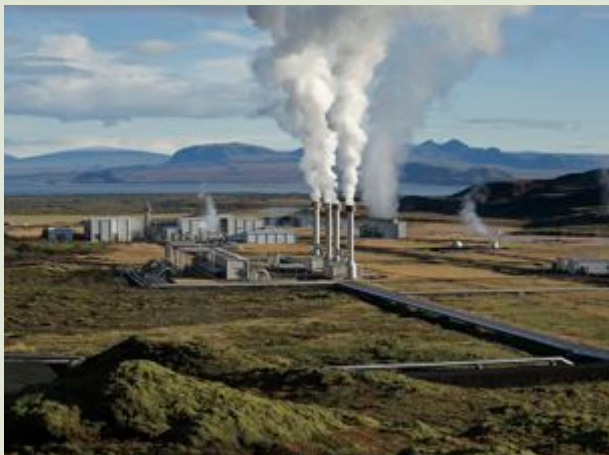
Geothermisches Kraftwerk in Island.
